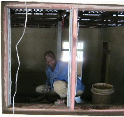
Výměna okna v nové části kanceláře
